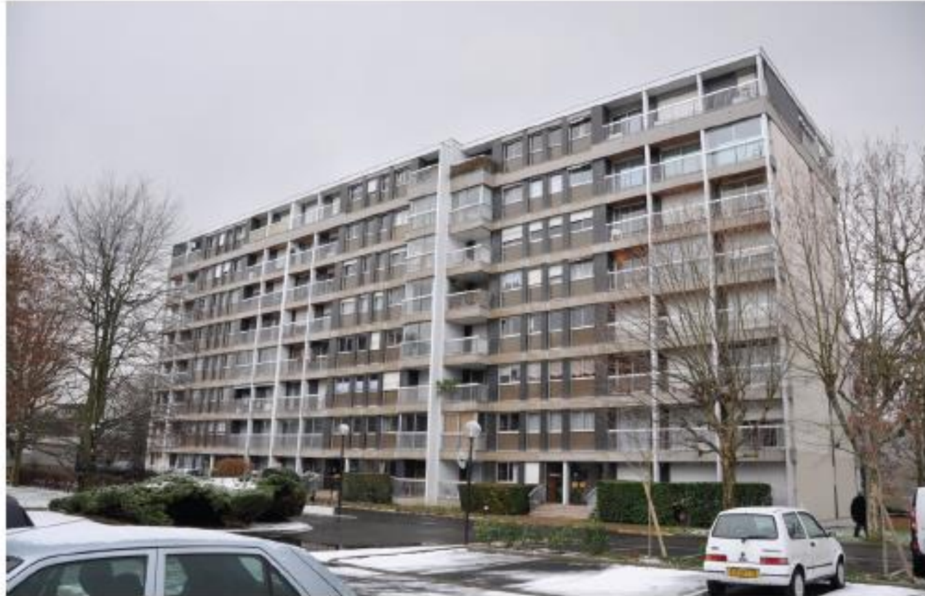
Bâtiment A avant réhabilitation (2011)
