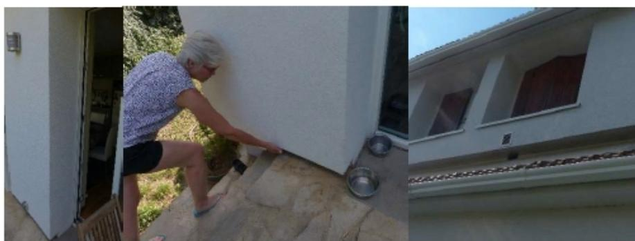
Isolation des murs ITE FDB 145 mm  $\rightarrow R = 3.8 \text{ m}^2.\text{K}/\text{W}$
