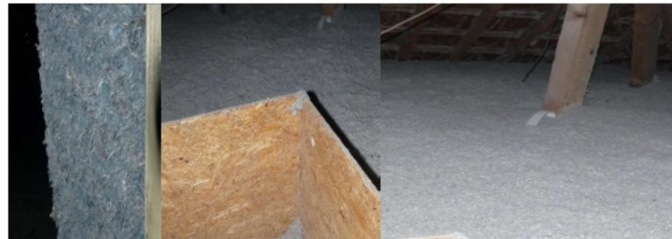
combles perdus : isolation en ouate de cellulose 335 mm  $\rightarrow R = 8.8 \text{ m}^2.\text{K}/\text{W}$
